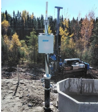
Intégration des anciens piézomètres et installation des nouveaux piézomètres automatisés
